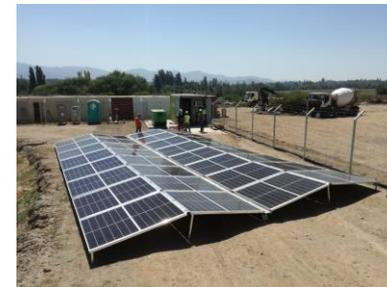
CRMET La Laguna, Talca (Chile): suministro eléctrico a 2 bombas de agua y campamentos de casetas – generador portátil FV (sustitución generador diésel 44KVA)
