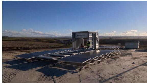
WSA Australia: sustituir parcialmente el suministro eléctrico de un generador de 50KVA por un generador portátil FV
