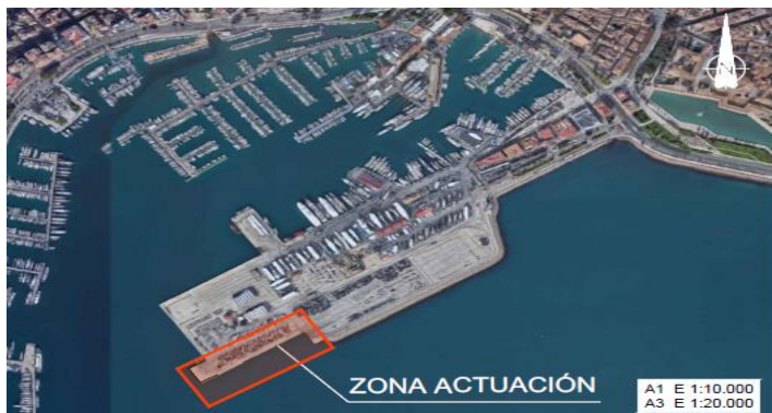
Puerto de Palma. Muelles Comerciales. 1MW 2.400.000€ 1º trimestre de 2024
